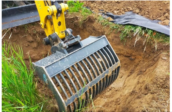
Gecontroleerd afgraven( 20 cm per keer)
