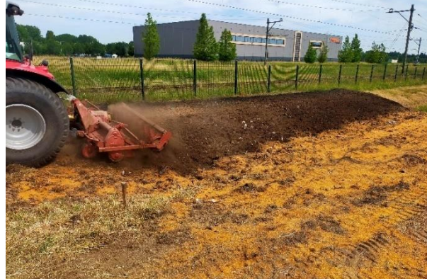
Fresen om granulaat in toplaag te verdelen
