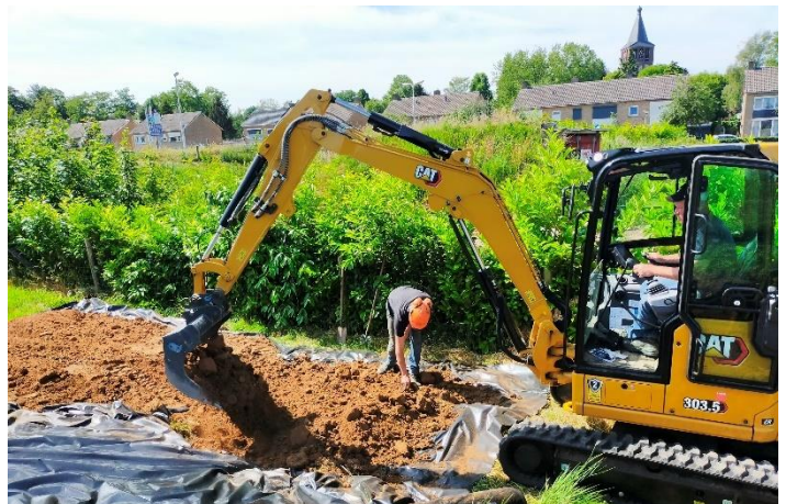
Worteldelen uit ontgraven grond zoeken
