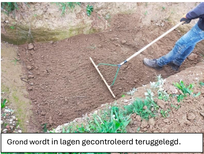
Grond vanuit depot wordt nogmaals gecontroleerd op wortelfragmenten.
