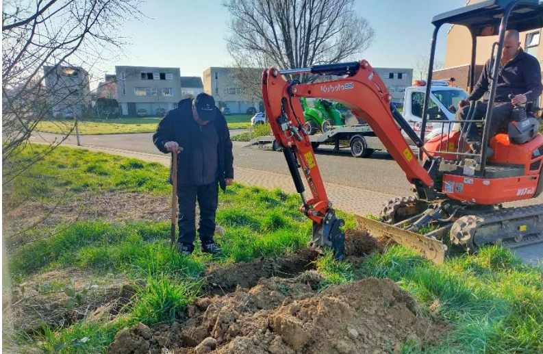
Graven van proefsleuven om omvang wortelzone te bepalen
