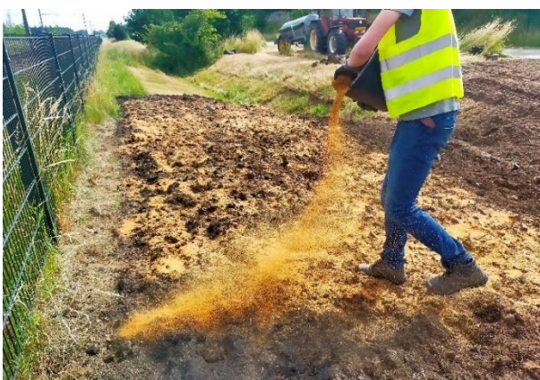
Aanbrengen granulaat met daarin bacterie
