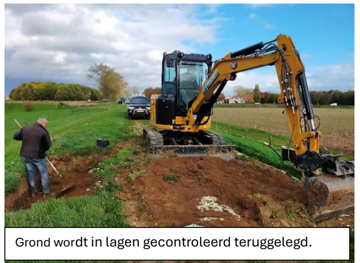
‘Gezuiverde’ grond wordt na enkele maanden teruggelegd in ontgravingen.
