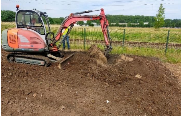
Spitten om worteldelen naar boven te brengen
